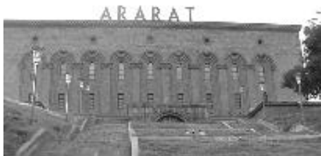
La fabrique de "cognac" la plus prestigieuse est située à Erevan. Les bâtiments, de tuf ocre et rosé, composent un ensemble architectural remarquable et se dressent sur les hauteurs dominant la rivière Hrazdan .
